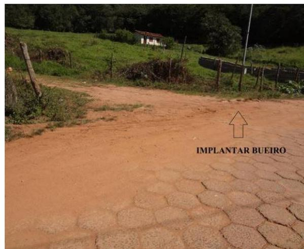
Figura 286 - Ponto com necessidade de implantação de bueiros;
